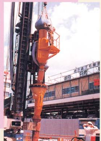
深層地盤改良
